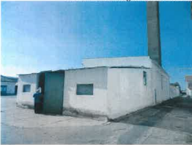
Fn7 Centrala termica / Fn8 Magazie centrala termica
