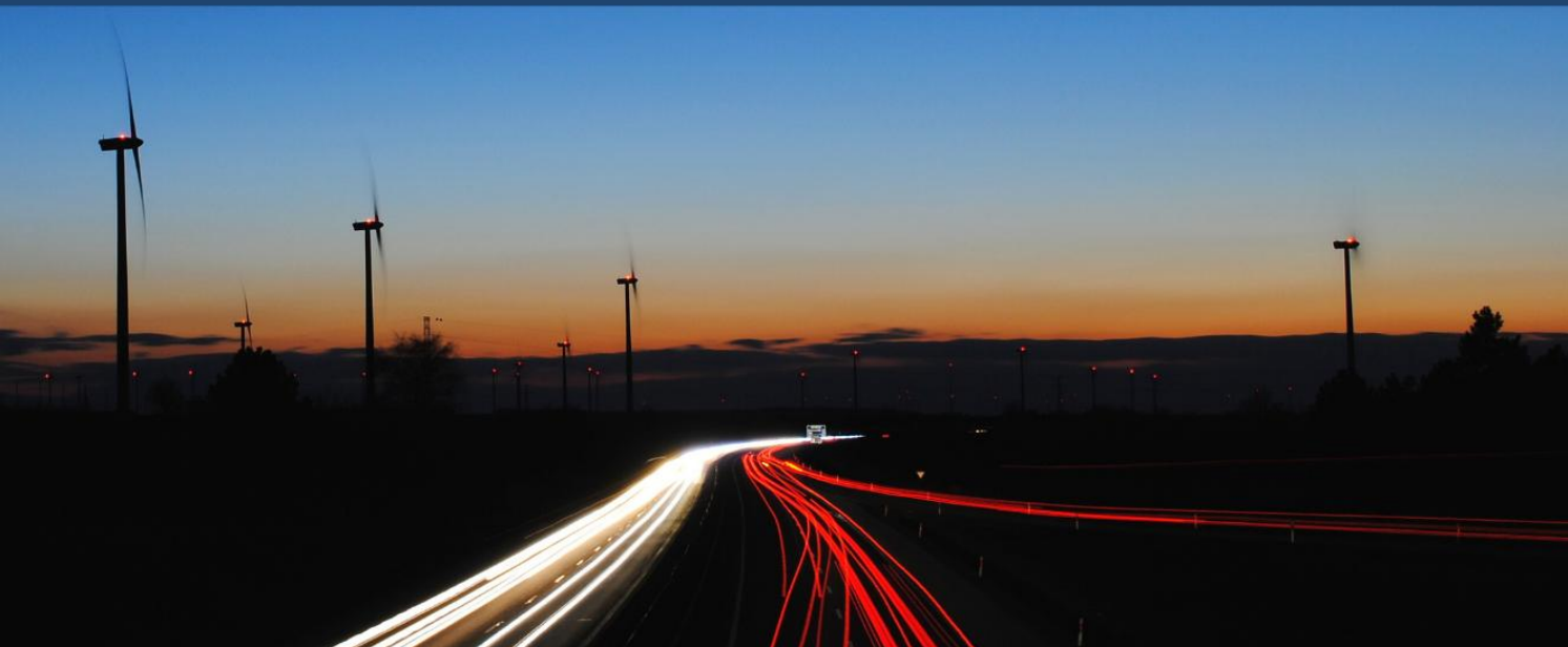
Parcul eolian de 158 MW din Ungaria, compus din 79 de turbine eoliene, achiziționat de Premier Energy.
